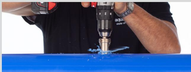
Durchbohren der Rohrwandung
