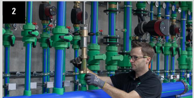
Montage des Anbohrwerkzeuges auf das Aufschweißsattelset
