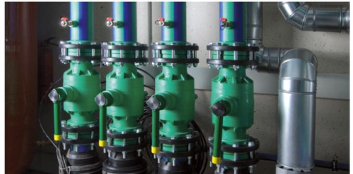
Die Steig- und Verteilungsleitungen für die Heizungsversorgung sollten in aquatherm blue pipe Verbundrohren geplant und ausgeführt werden.
