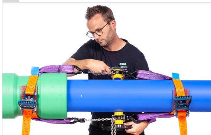
**10** Steckmuffe gleichmäßig bis zur markierten Einstecktiefe auf das Rohr ziehen.
