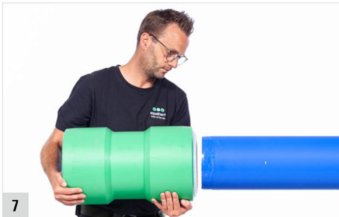
**7** Steckmuffe auf das Rohrende aufsetzen und über die erste Dichtung hinweg auf das Rohr schieben.
